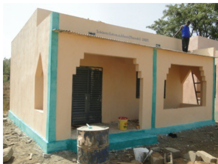
20/12/2014 : Fin des travaux
